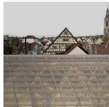
Museum Historische Oberamteistraße, Wulf Architekten
